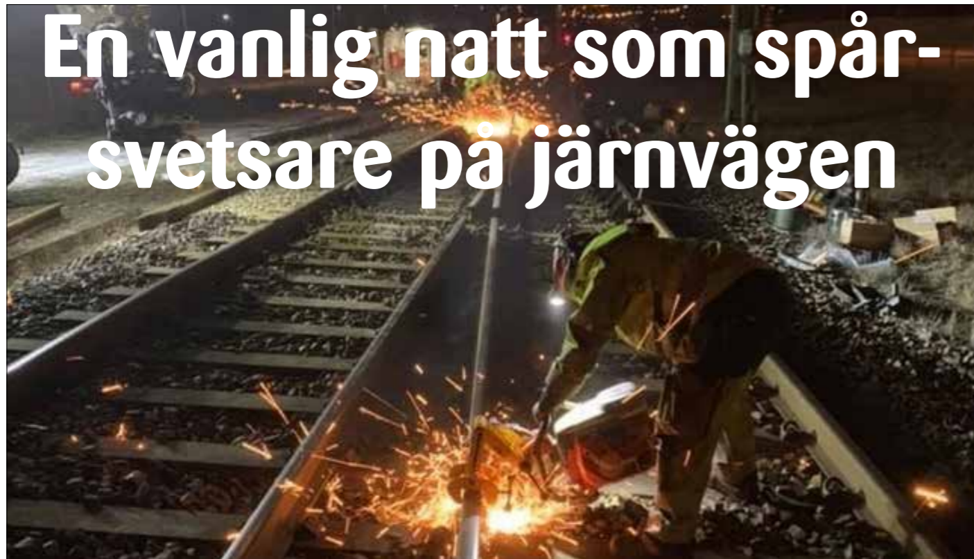
Inkapning av passräler efter det att den gamla korsningen kapats bort och den nya lagts in på rätt plats. Kapningen utförs av Magnus Björkman från MP Spårservice och Björn Hagberg från NRC Group.
